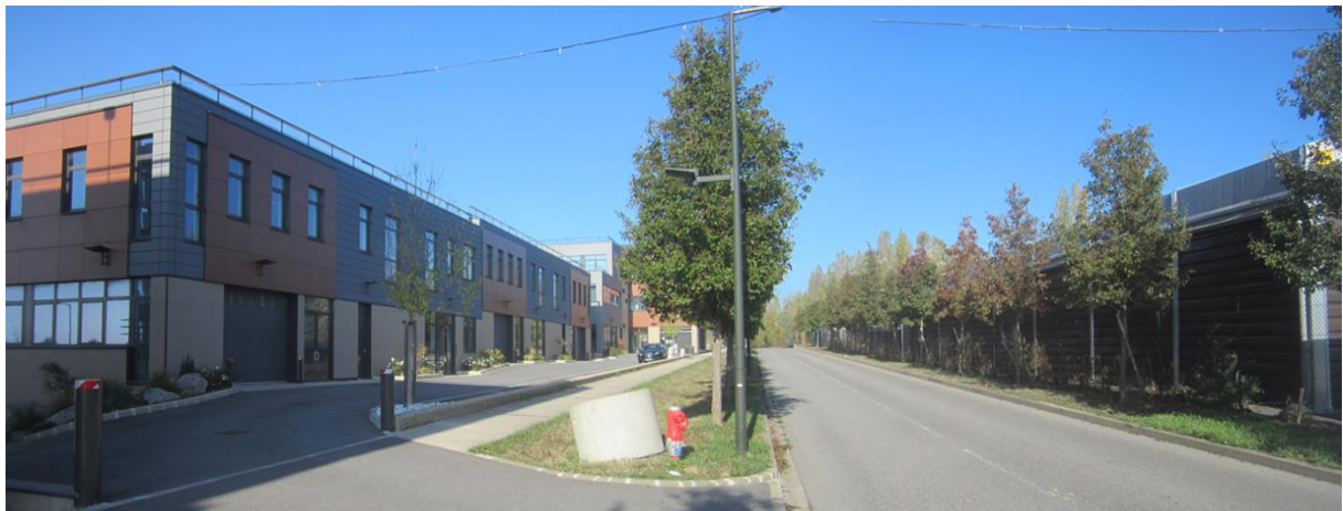
Alignements d'arbres présents le long de l'Avenue de l'Europe, artère principale du secteur – Source : Nexity
