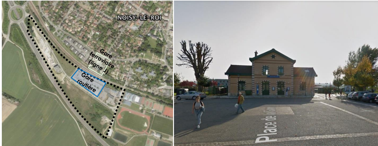
Localisation des gares par rapport au site de projet (à gauche) et parvis de la gare de Noisy-le-Roi situé au nord du site de projet (à droite) – Source : Google Map/Google Streetview
