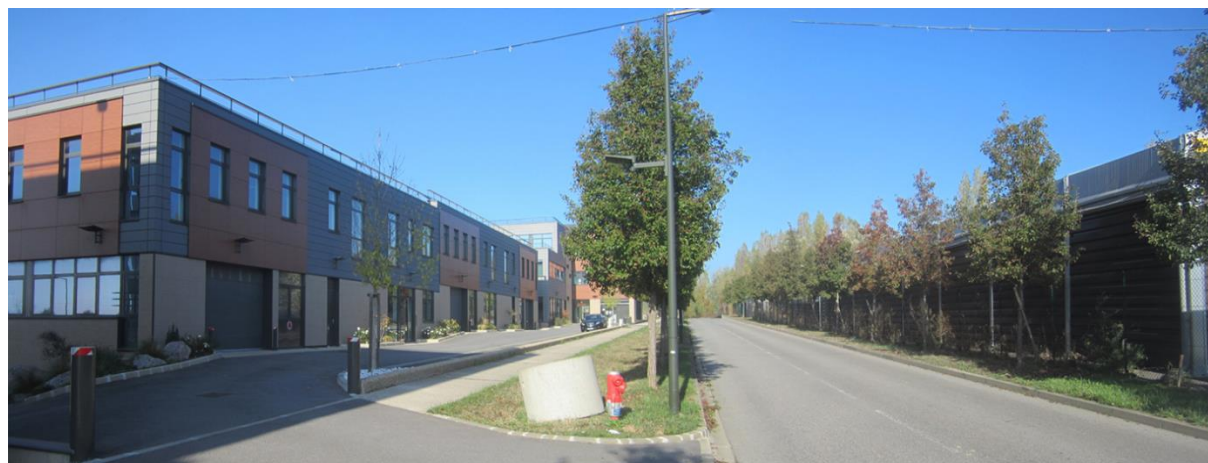
Alignements d'arbres présents le long de l'Avenue de l'Europe, artère principale du secteur – Source : Nexity
