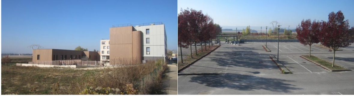
EHPAD « Résidence de Maintenon » et le parc relais de la gare routière, récent construit sur le secteur de projet – Source : Nexity
