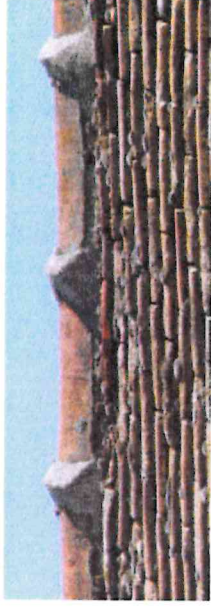
Les tuiles faitières sont jointes au mortier.
