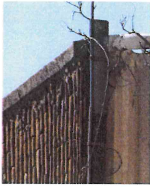
Le pignon est « débordant »
