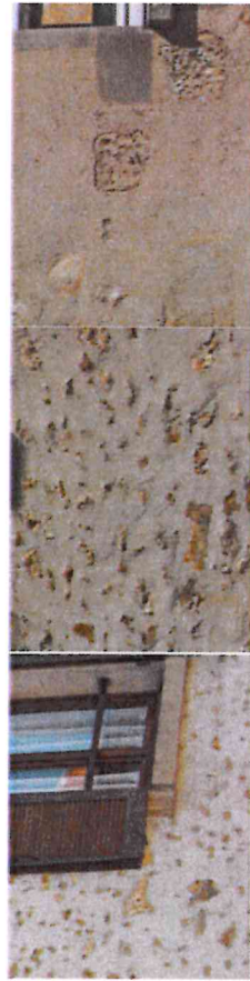
Exemples de finitions « beurrées » au mortier, laissant affleurer les matériaux de la maçonnerie.
