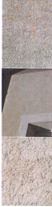
Les finitions d'enduit sont grattées, plus ou moins fin
